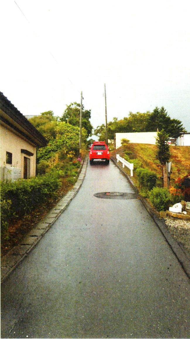
←施工前の町道明神下 9 号線
