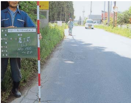
着工前の側溝（鶉久保地区）
