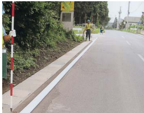
完成後の側溝
