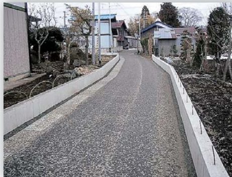
整備後の道路
