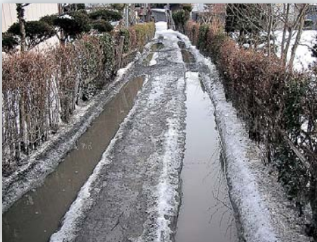
整備前の道路
