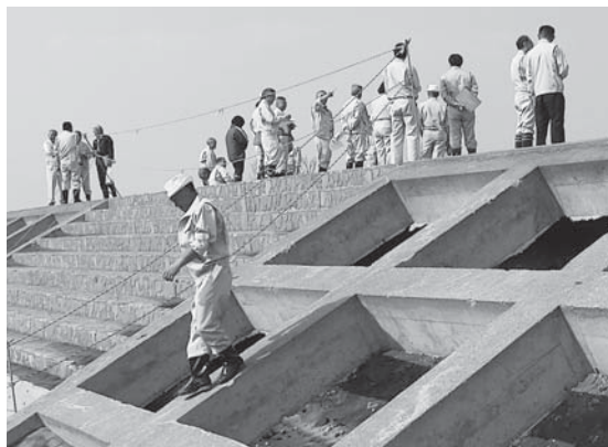
堤防が壊れた二川目海岸
