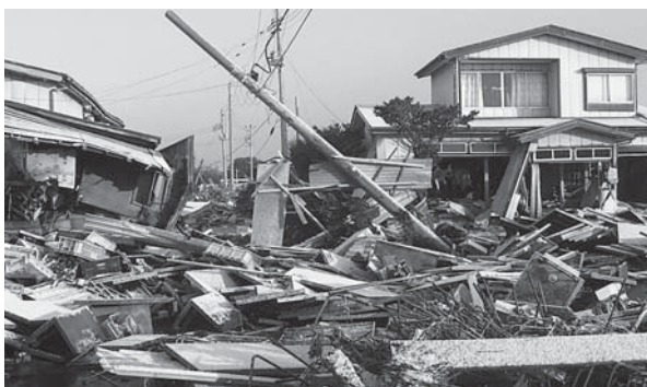
津波により被災した川口地区
