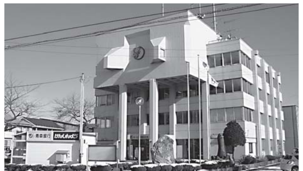
耐震性能が非常に低いと診断された分庁舎
