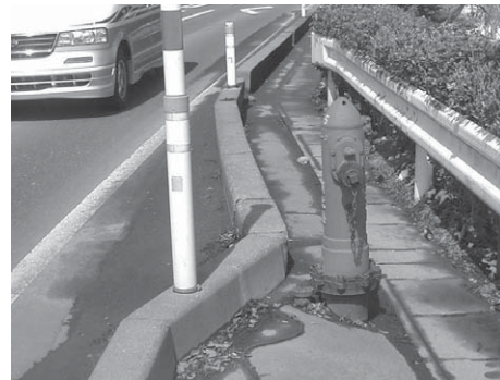
歩行に障害な消火栓（木ノ下地区）
