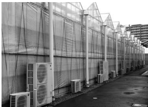
空調管理された植物工場
