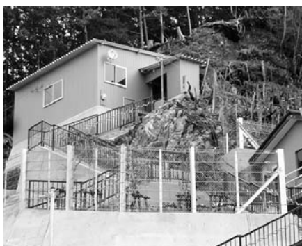
山の斜面に設けられた避難所
