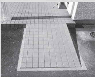
▲スロープ設置①
