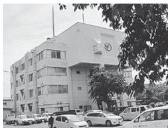
建設後43年が経過した分庁舎
