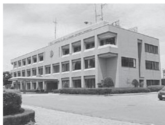
建設後35年が経過した本庁舎
