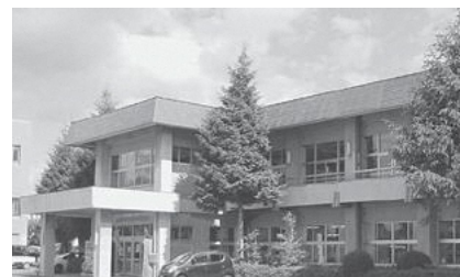
建設後49年が経過した中央公民館
