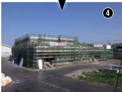
▲外壁等工事中（平成29年7月21日）
