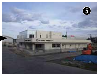
▲内装等工事中（平成29年9月23日）
