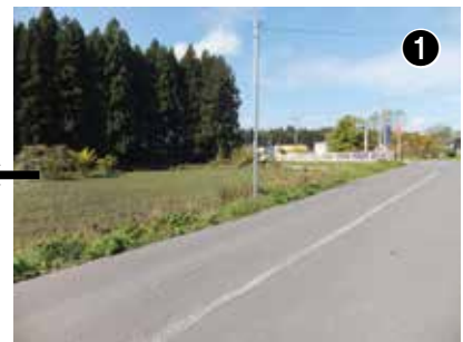
▲着工前の建設地
