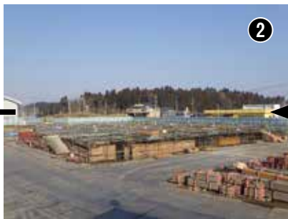
▲基礎工事中（平成29年4月4日）
