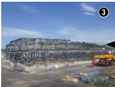
▲鉄骨工事中（平成29年5月29日）
