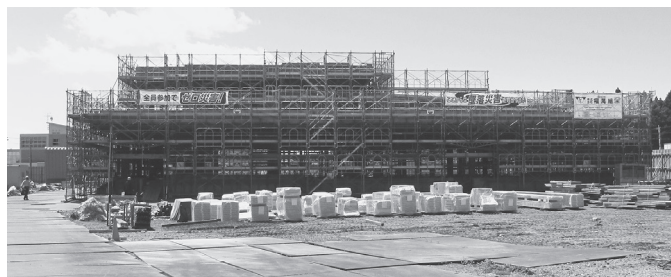
来年度の業務開始に向け建設中の新学校給食センター
