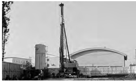
下田中学校の隣に建設中の 新学校給食センター
