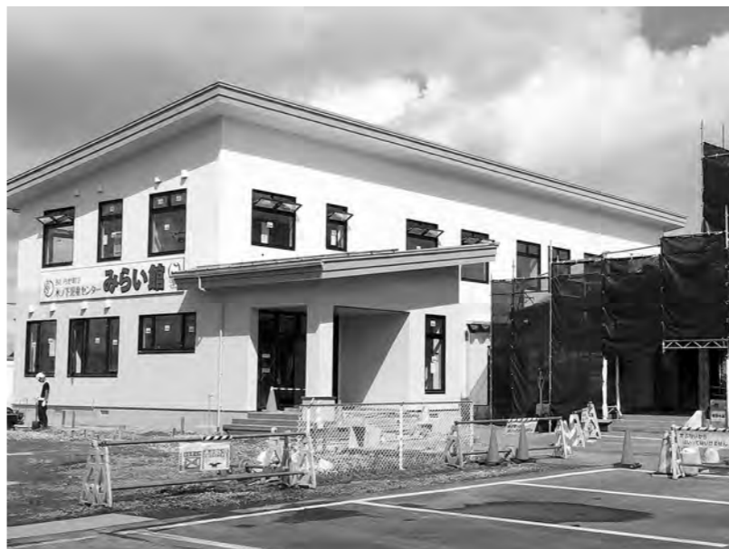
増改築工事中の北部児童センター
