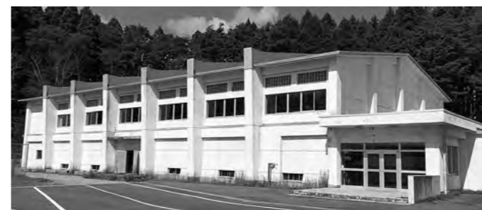
建築後38年経過した百石中学校講堂
