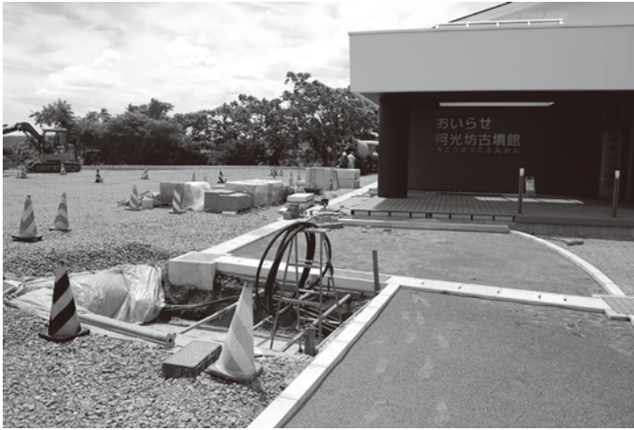
▶着々と工事が進む古墳館の様子
