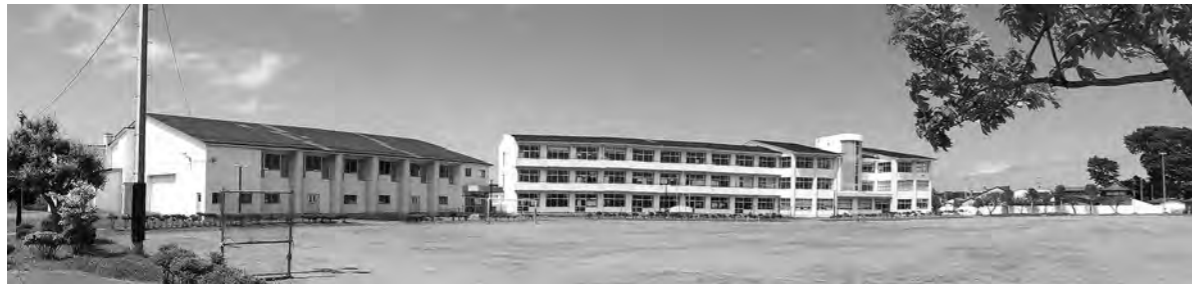
建設後23年が経過。屋根・外壁等の改修工事を実施
