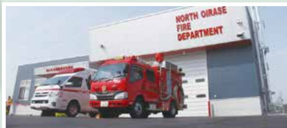
▲八戸地域広域市町村事務組合おいらせ消防署北分遣所が落成。北部地区の防災拠点に
