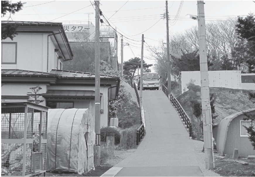
手すり・滑り止めが施されたアプローチ道路（町道明神下9号線）
