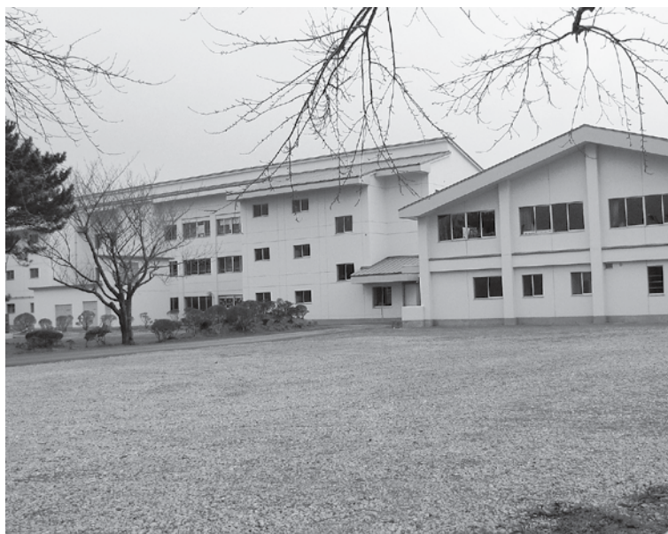
プール解体後、更地となった甲洋小学校敷地
