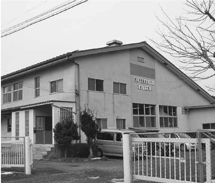
建設後、40年以上経過した現在の学校給食センター
