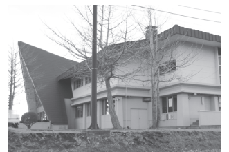
▲外壁塗装補修等を行ういちよう体育館
