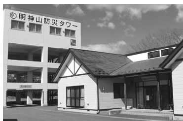
▲明神山コミュニティ防災センターと防災タワー
