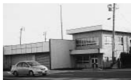
解体予定の旧八戸消防署北分署
