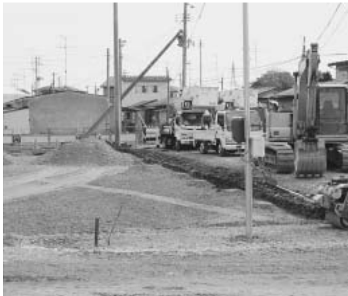
町発注の住宅立て替え工事
