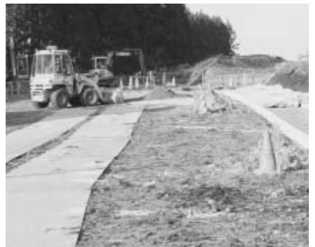
町発注の道路改良工事
