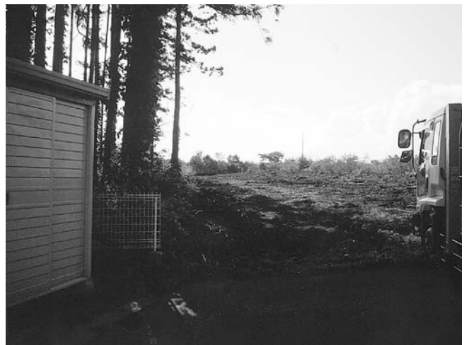
造成の進む北部地区
