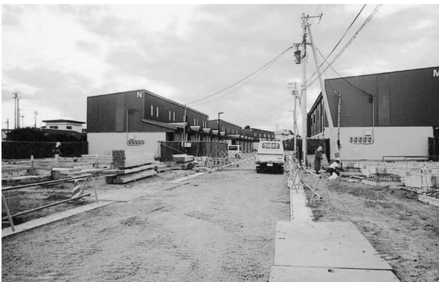
公正、透明な入札で効率的公共投資を！！ （町営住宅 奥入瀬西団地建設工事）
