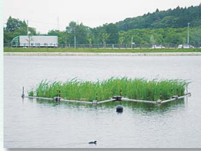
水辺環境保全事業で設置された間木堤の浮き島
