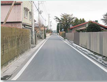
町道整備事業で整備された木内々・本町線側溝整備工事
