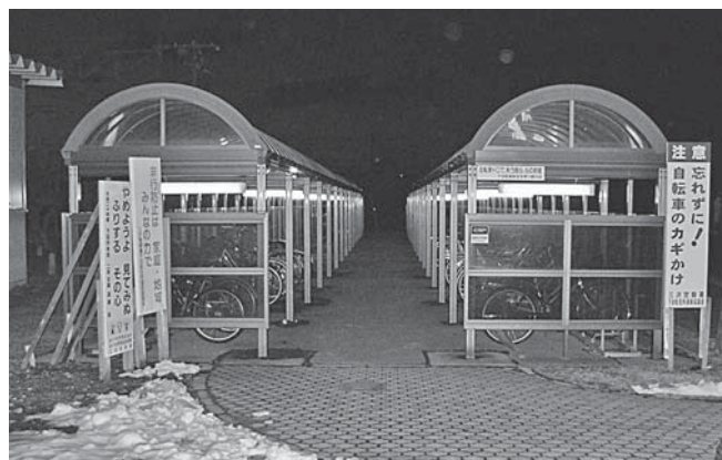
青色防犯灯を設置した下田駅前駐輪場
