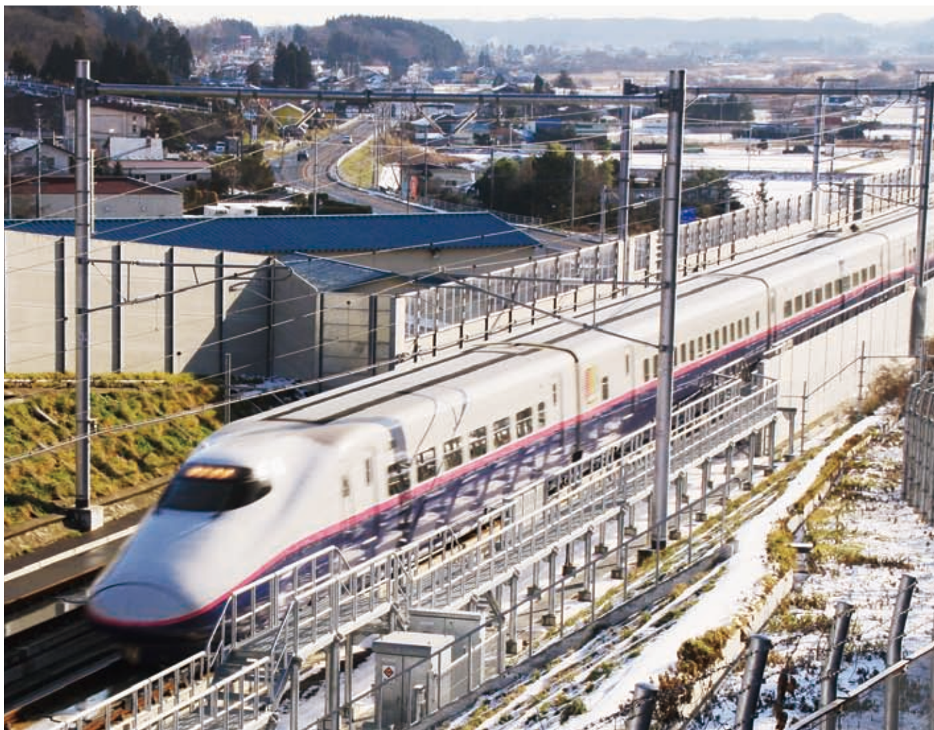
おいらせ町錦ヶ丘トンネル付近を走行する東北新幹線「はやて」 (写真提供：おいらせ町 西館東城氏)
