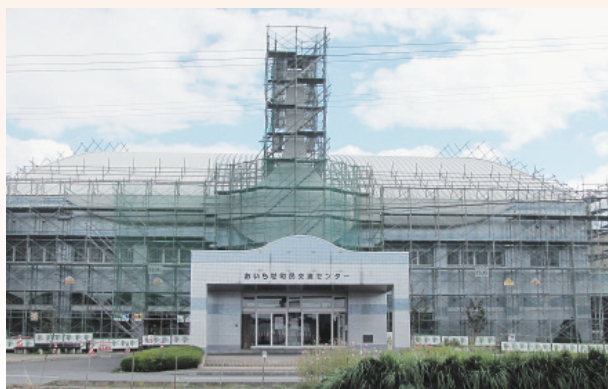
改修工事が進む町民交流センター
