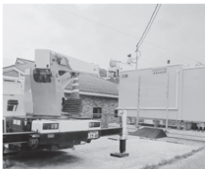
光ファイバー網の設置工事
