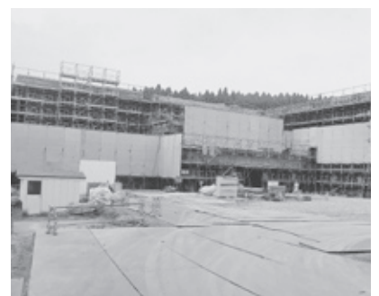
百石中学校改築工事
