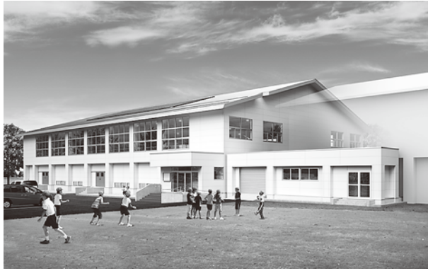
木ノ下小学校第2体育館イメージ（11月完成予定）
