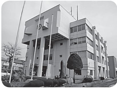
耐震補強された分庁舎
