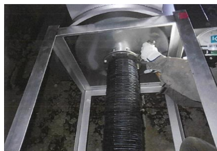
処理装置機能強化更新工事の様子
