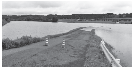
▲幸橋南側付近の冠水した道路 (木内々と三本木を結ぶ道路)
