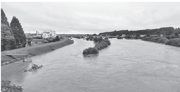
▲堤防付近まで溢れそうな病院近くの奥入瀬川の様子
