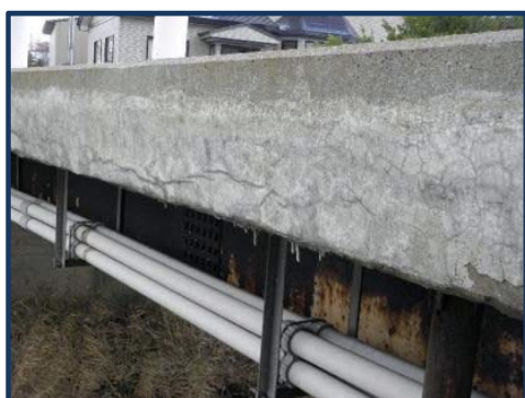
凍害※2と思われる損傷（参考例）
