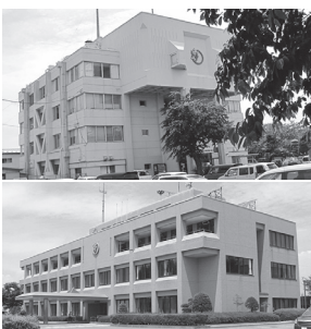
▲暖房や水道の故障等の老朽化が進み、浸水が想定されている両庁舎
