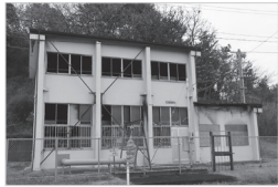
▲揚水機場施設
