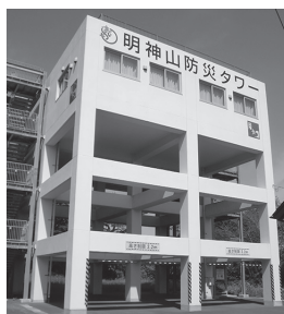
▲24mの津波でも避難スペースまで浸水しない明神山避難タワー
