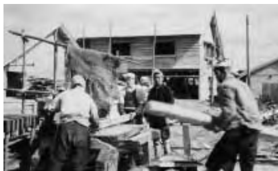
復興の槓音／焼け跡に施設された移動製材団の活躍（四丁目付近）
