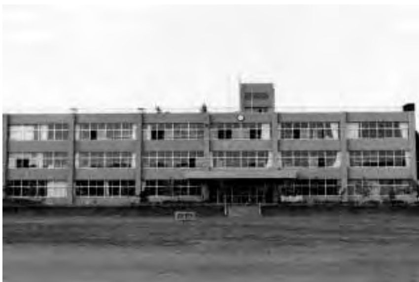
昭和48年／木ノ下小・中学校防音校舎完成
