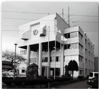
分庁舎は耐震診断で「要補強」と判定されました。耐震性を高め、人命の安全を確保するため、7月より改修工事を行います。
