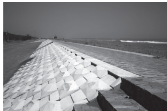
▲復旧した二川目一帯の海浜公園付近の防潮堤
