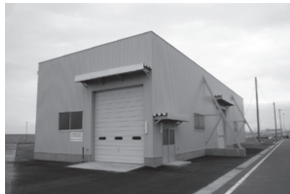
▲完成した2棟目の漁具倉庫
