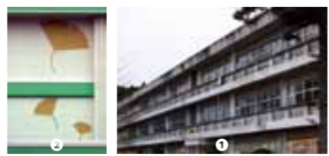
①老朽化した現在の百石中学校校舎。生徒の安全確保のため、新校舎建設が望まれていた ②新校舎の外壁に描かれたイチヨウの葉のイラスト。生徒のアイデアで実現した唯一無二のデザイン
