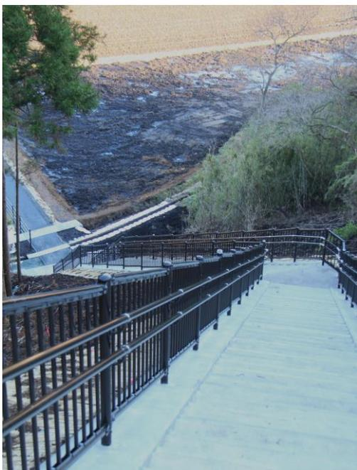
①③④高台に迅速に避難できる階段です。夜間はソーラー電池により、手すりのライトが点滅します。
