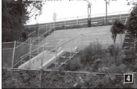
4号避難階段（国道45号沿い）
