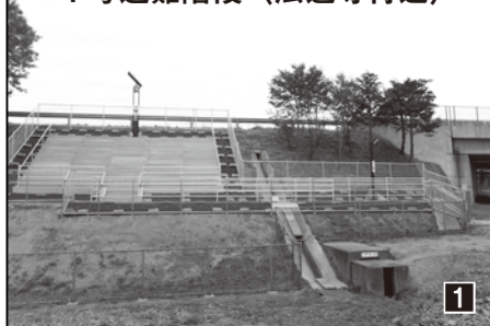
1号避難階段（法運寺付近）
