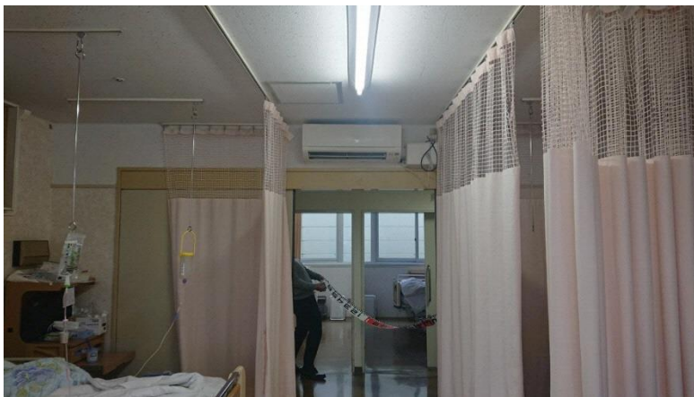
(病室内エアコン)
