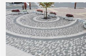
参考写真 インターロッキング舗装
