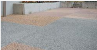
参考写真 樹脂舗装洗い出し
