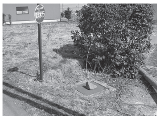
▲撤去される防火水槽
