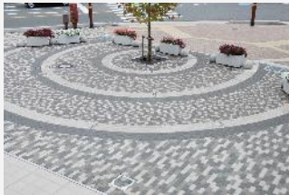
参考写真 インターロッキング舗装
