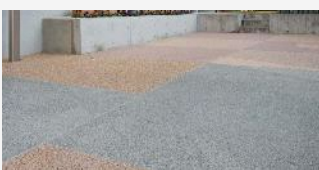
参考写真 樹脂舗装洗い出し
