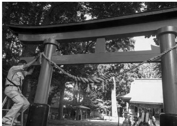
▲張り替え作業の様子
