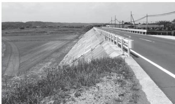
▲補強工事が完了した堀切川地区
