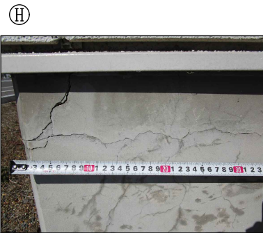
欠損補修 : W100×H100×D100
