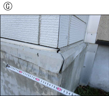
欠損補修 : W900×H100×D50
