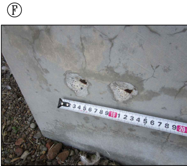
欠損補修 : W150×H150×D20
