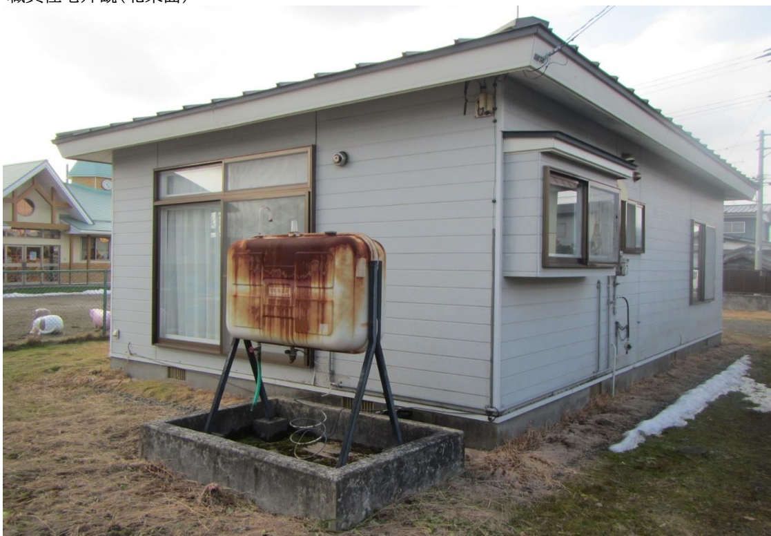
職員住宅外観(北東面)
