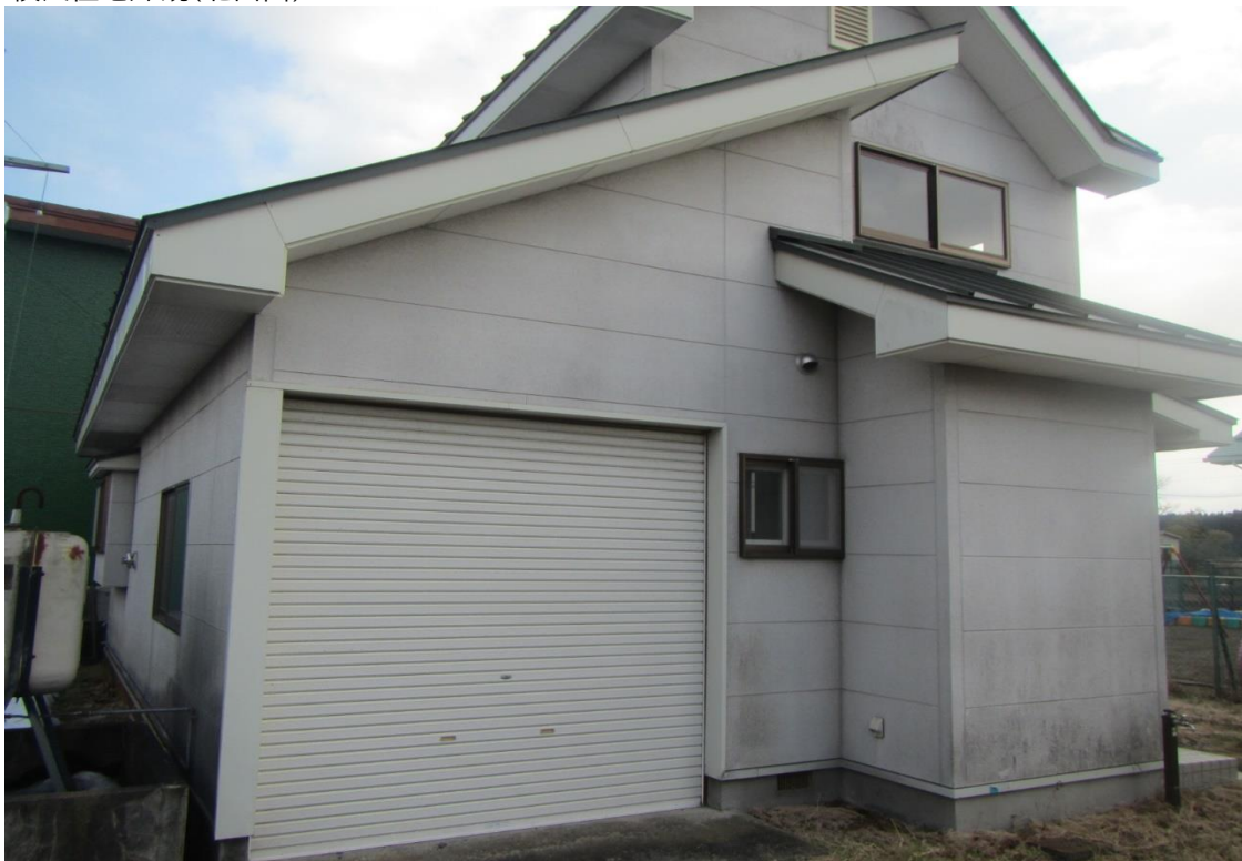
校長住宅外観(北西面)
