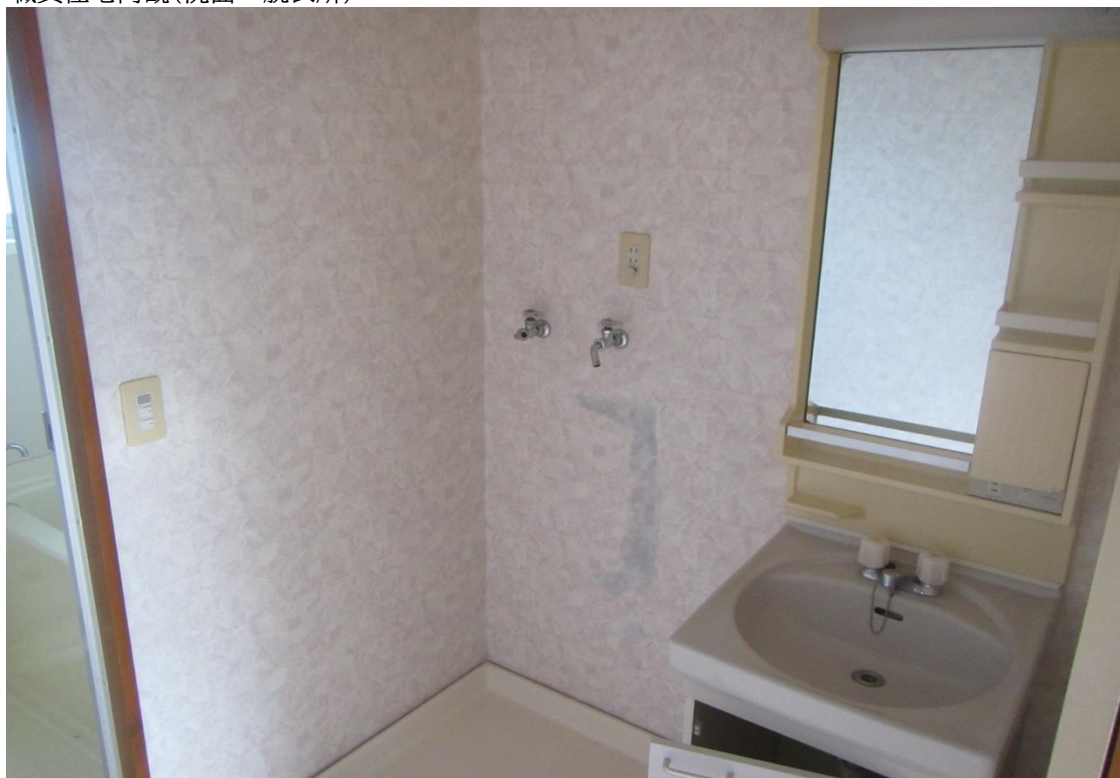
職員住宅内観(洗面・脱衣所)
