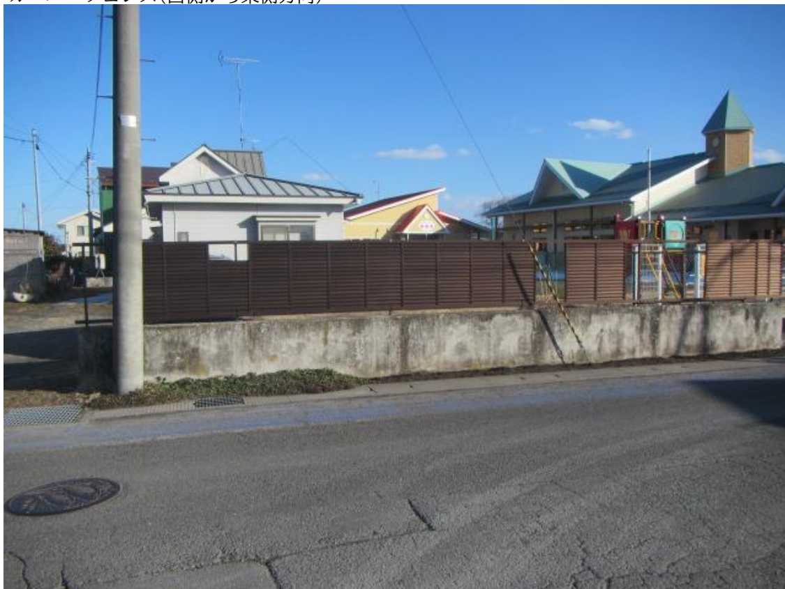
ルーバーフェンス(西側から東側方向)
