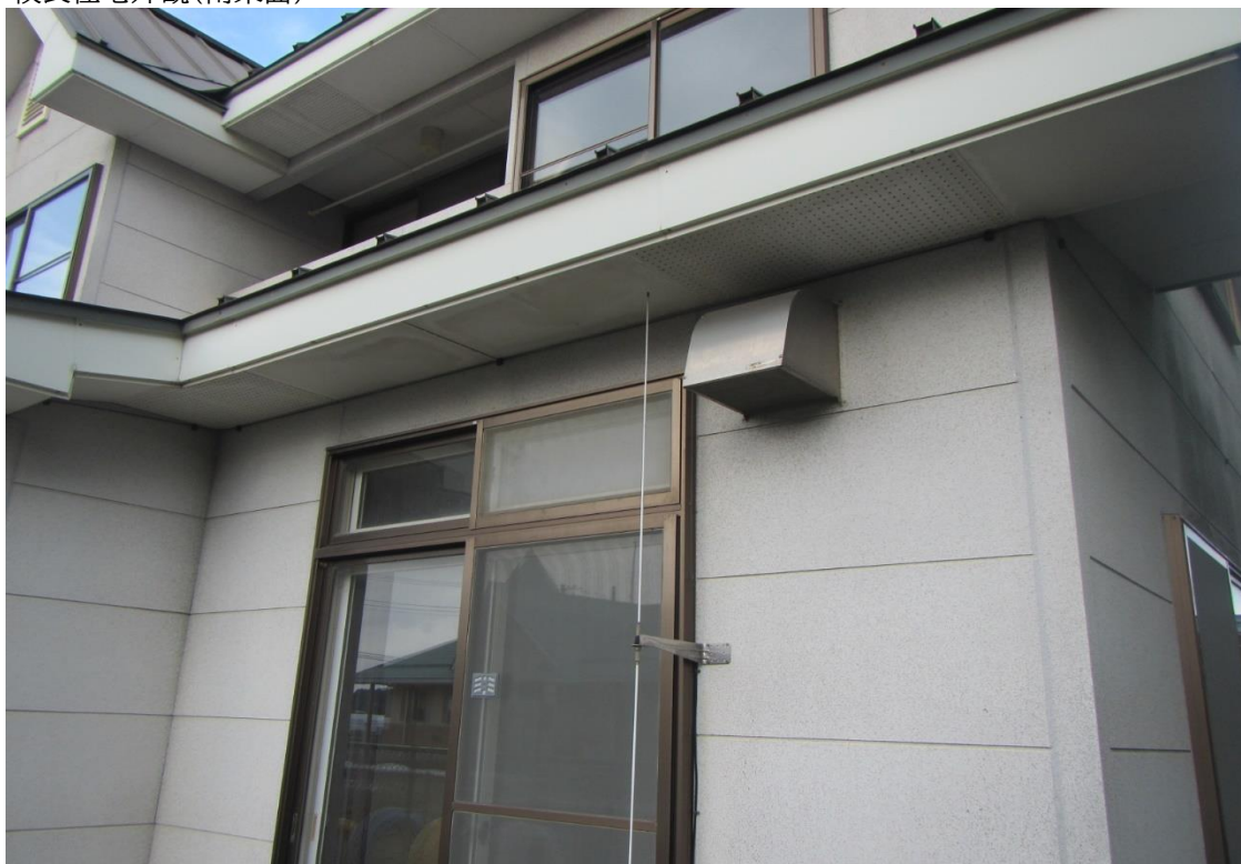
校長住宅外観(南東面)
