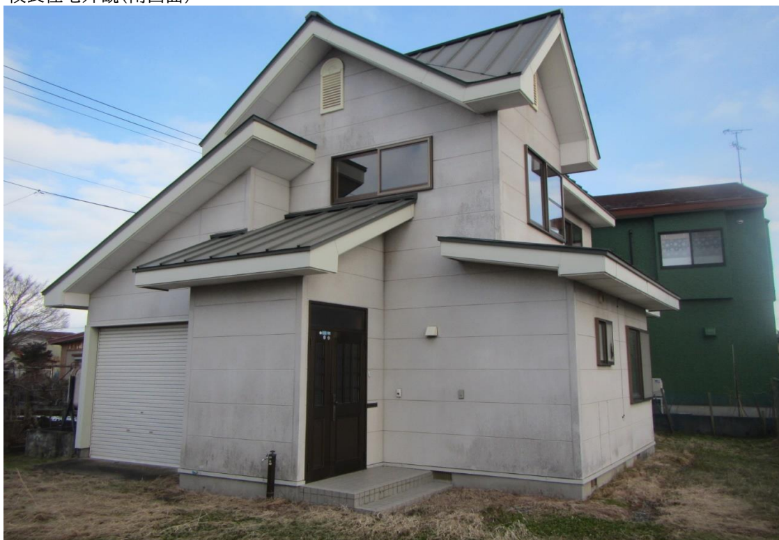
校長住宅外観(南西面)
