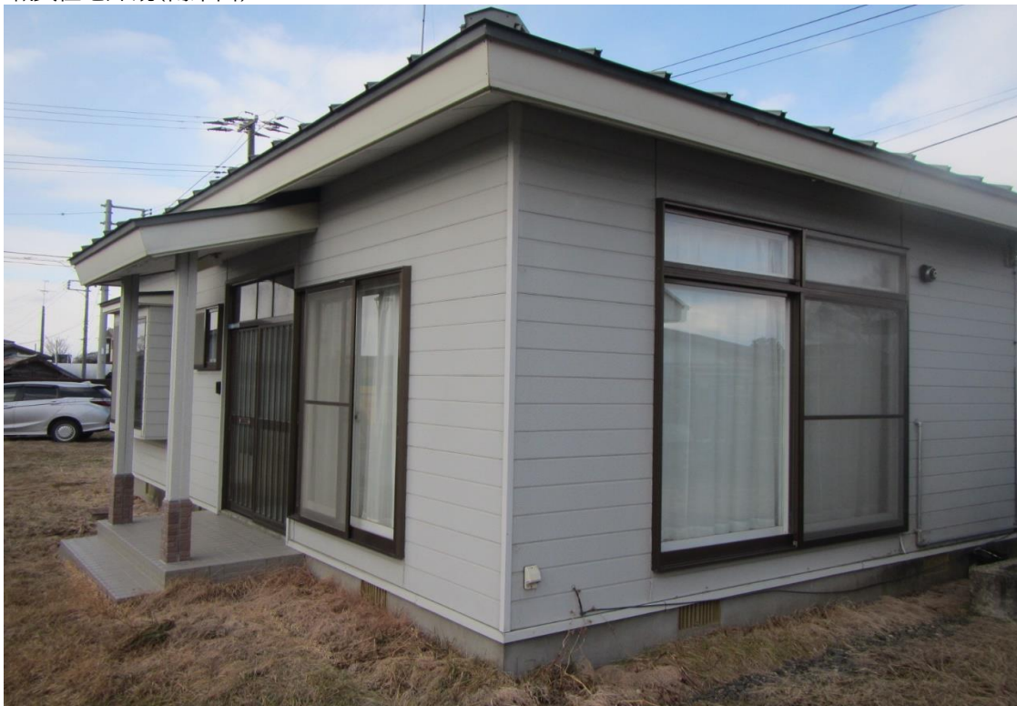
職員住宅外観(南東面)
