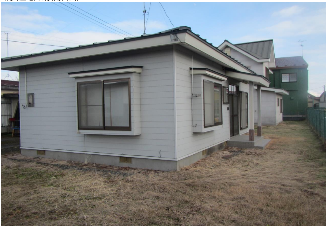
職員住宅外観(南西面)
