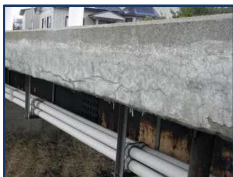
凍害※2と思われる損傷（参考例）
