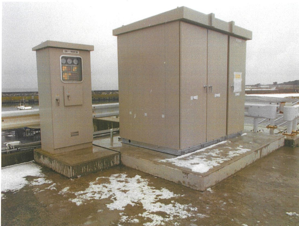
【左側】機側操作盤（既存）、【右側】遠隔操作用蓄電池収納ボックス（新設）
